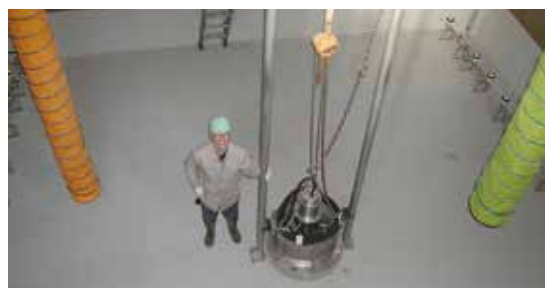
図2 廃水処理装置の改修工事
